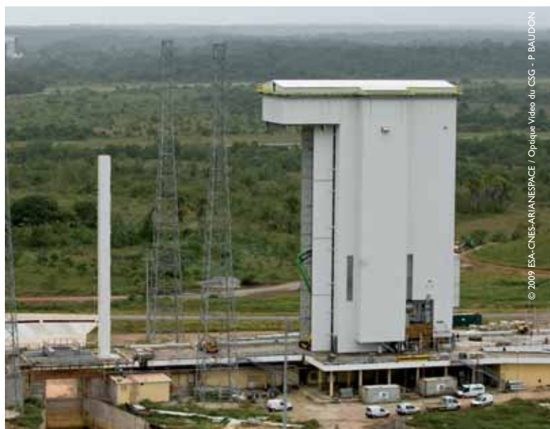
Siège de toutes les opérations d'assemblage, le portique de Vega se rétractera 2h avant le H0.
